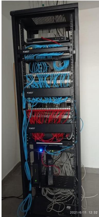
Imagen 11: Rack con la instalación y los equipos de red
