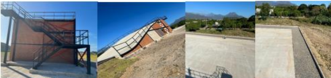
Estructura metálica escaleras
