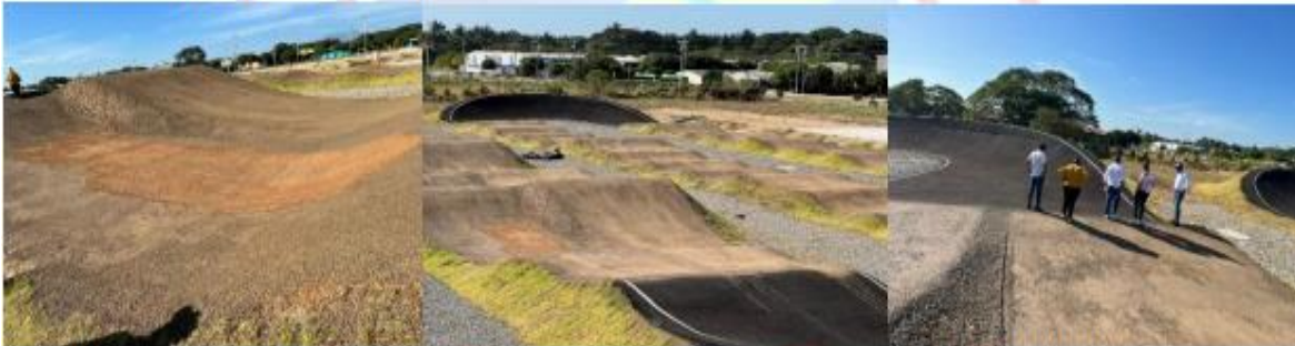
Pista BMX Tramos relleno seleccionado compactado y mezcla densa en caliente (Asfalto)
